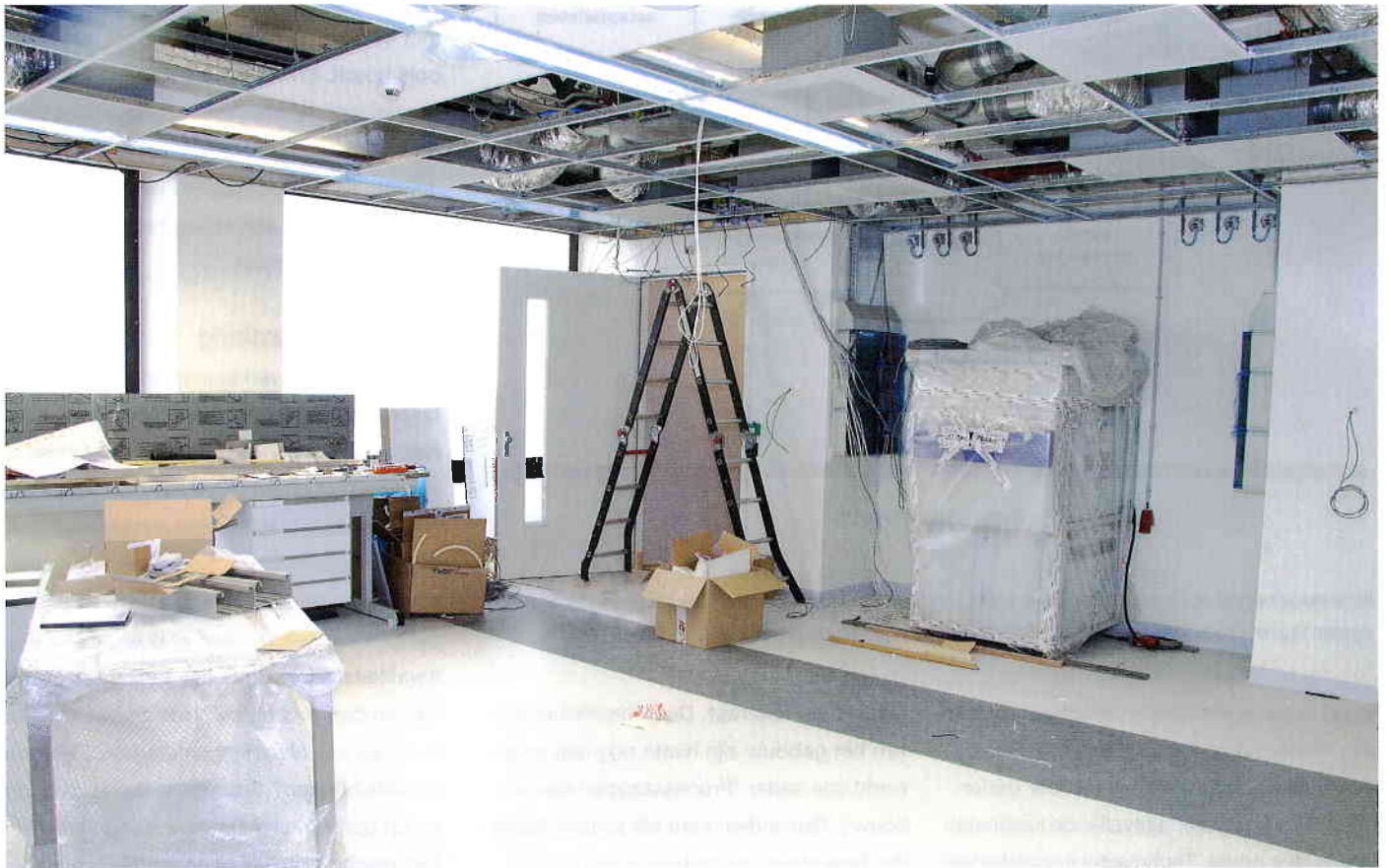
Nieuwbouw van microbiologische laboratoria.
